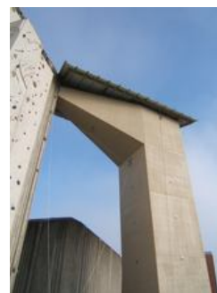
Arche extérieure Météo France (Toulouse)
